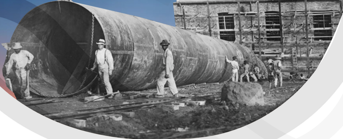
Construção dos condutos forçados da Usina de Piabanha, 1908
