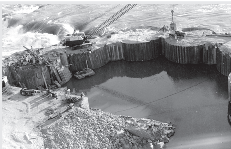
Ensecadeira celular para a construção da barragem com comportas na primeira metade do braço principal do rio São Francisco. Delmiro Gouveia, AL / Paulo Afonso, BA. 1952
