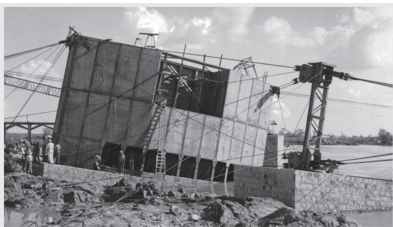
Caixão flutuante metálico, conhecido como “navio”, utilizado na primeira etapa de fechamento do braço principal do rio São Francisco. Com 18 metros de comprimento, 10 de altura e 6 de largura máxima, o equipamento podia ser deslocado por cabos de aço presos a tratores nas duas margens do rio. Vazio, pesava 125 toneladas e cheio d’água, 350 toneladas. Delmiro Gouveia, AL / Paulo Afonso, BA. Novembro de 1950
