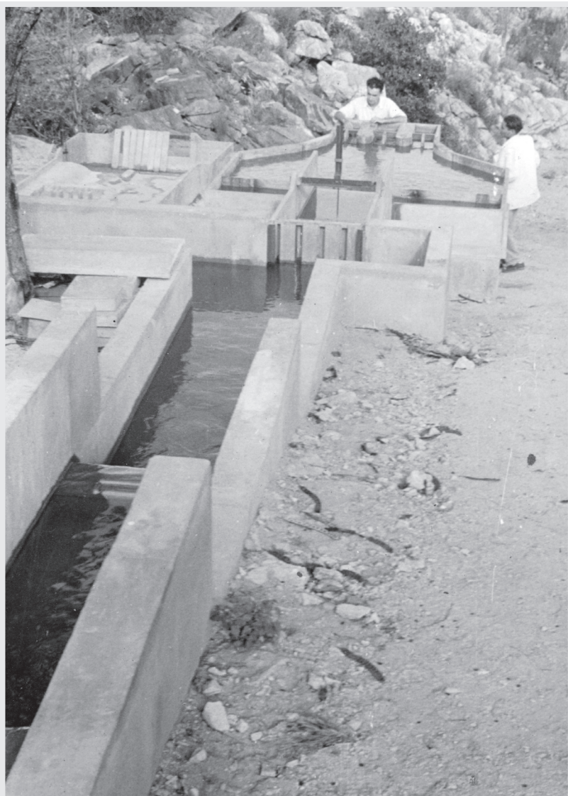
André Balança trabalha no modelo reduzido da tomada d'água da usina de Paulo Afonso I. Paulo Afonso, BA, [1952-1954]
